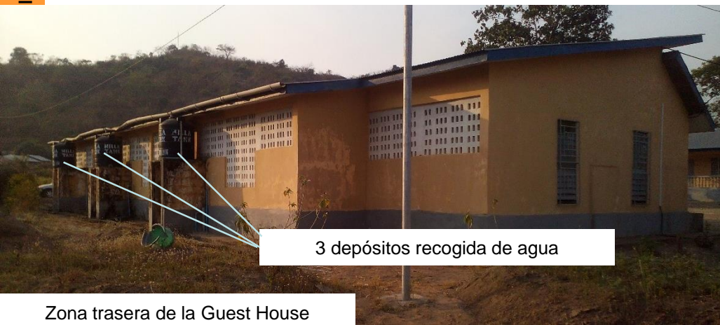
Sistema propuesto julio 2014 con desvío de agua a depósito enterrado y posterior bombeo a depósitos elevados
