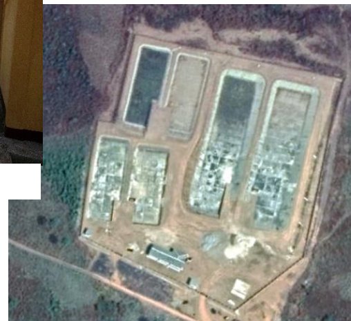
Balsas de depuración y zona de residuos
