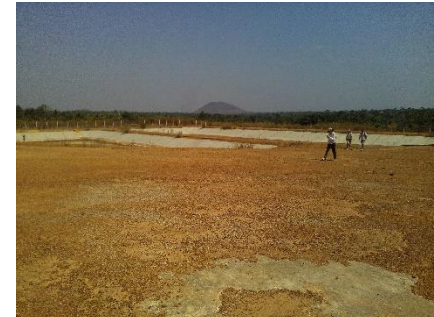
Balsas depuración lodos fecales
