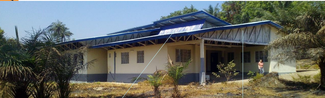
Zona de entrada de agua reparada
